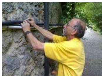
Unser Freund Claudio, Meister im Elektrofach, hat auch im Juni wieder viel in seiner freien Zeit für die Tiere bei uns installiert.
