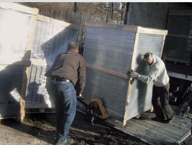
Viele helfende Hände waren für den Aufbau nötig.
